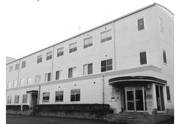
バスの整備施設を備えた本社屋(滋賀県草津市)
